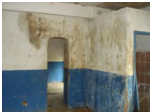
Prédio do antigo posto médico, posteriormente Abrigo Renascer
