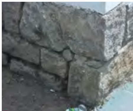
Beiral com ajuntamento e cobertura de pedras (2012). Acervo CRPH-DC
