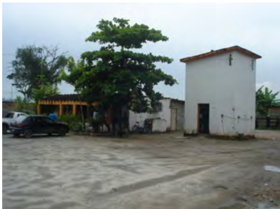
Imagens do prédio da Tulha Principal da Fazenda do Iguaçú. Fábrica de Manilhas, 2008 Acervo do CRPH-DC
