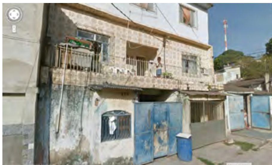
©2013 Google Data da imagem: agosto de 2011 – Street View
