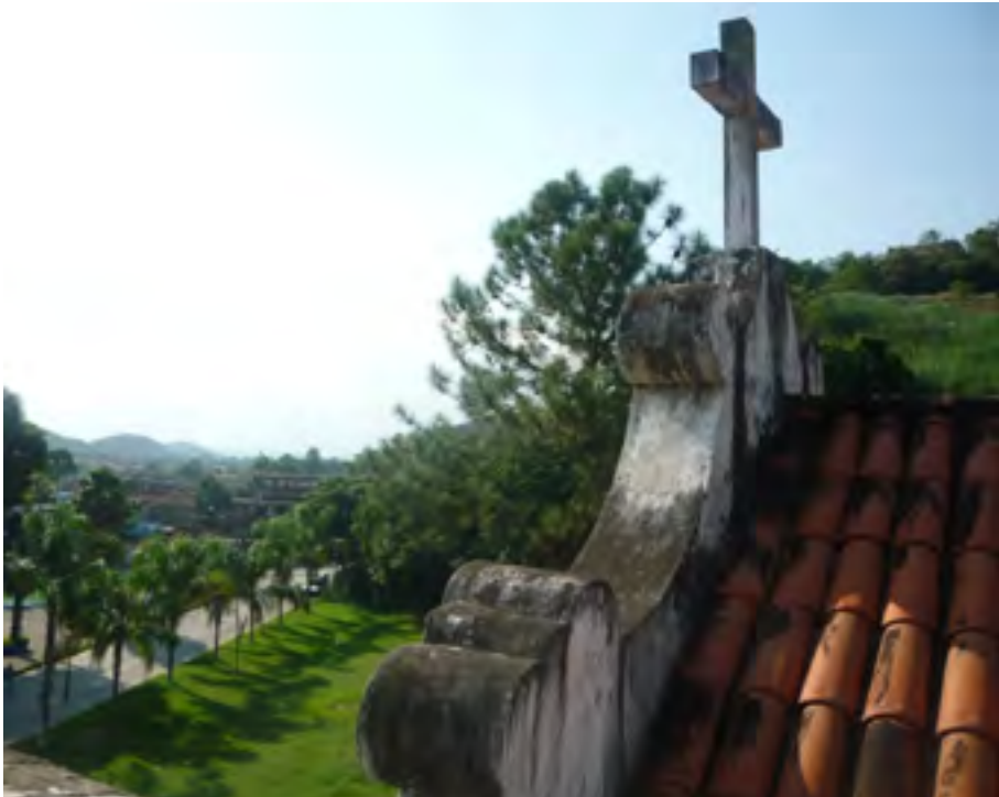
Vista da torre do sino. Fotografia: Aline Nascimento/2013
