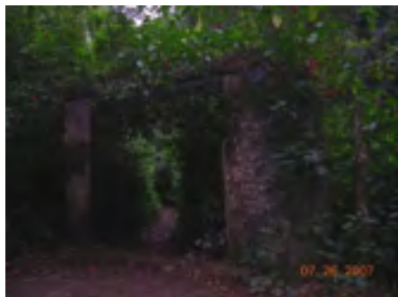
Portal de passagem do caminho de integração Caminho do Garcia Paes com o Caminho do Imperador
