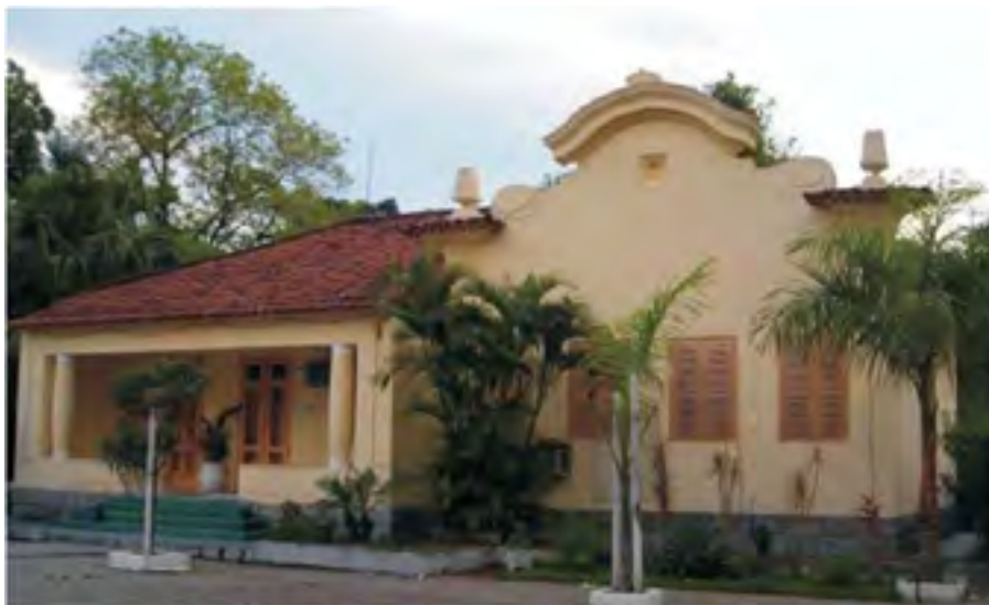
Fachada da casa do Administrador, em 2011. Acervo CPPH/DC - Museu Vivo do São Bento
