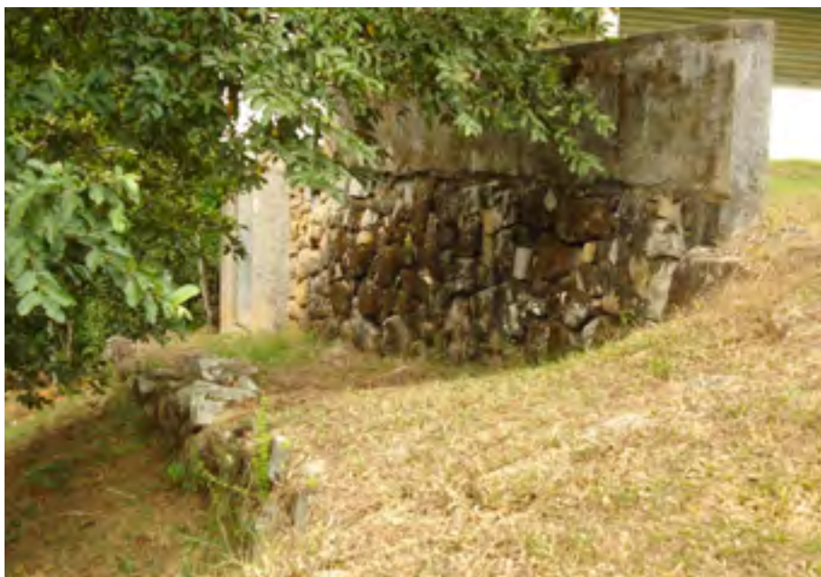
Escada lateral da capela
