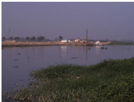
Figura 51: Obra do Projeto Iguaçu ocorrendo na margem do bairro Pilar, do lado oposto ao São Bento. Observa-se o talude sendo construído, que a população local teme que funcione como um dique. Fotografia de André Tenreiro (agosto de 2010)
