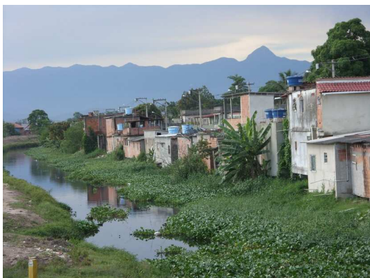
Figura 38: Ocupação em área de risco de inundação no bairro do Pilar. (Foto: Kátia Paz).
