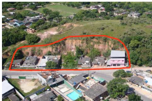
Figura 34: Ocupação em área de risco de deslizamento na Rua Campestre, na localidade conhecida como Jardim Líder em Duque de Caxias
