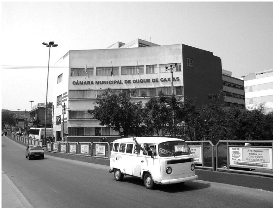
O viaduto uniu a cidade partida.
